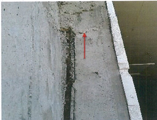
Fotografía N° 9, 23-06-215, intersección de muros ejes D, D1-38,39.
