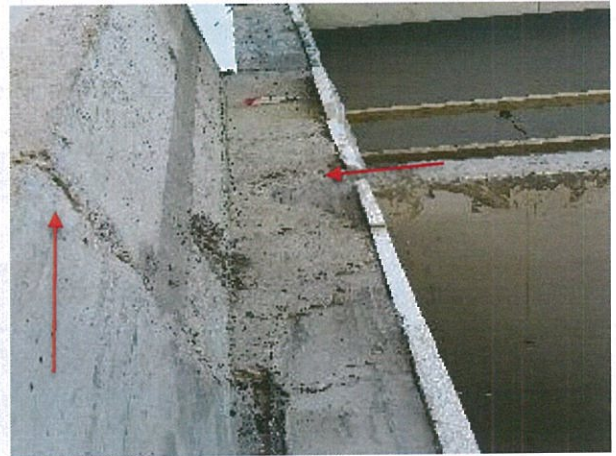
Fotografía N° 10, 23-06-215, intersección de muros ejes D, D1-38,39.
