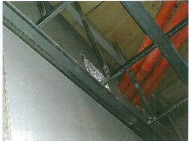
Fotografía N° 24, 30-06-2015, pasadas en muro del eje 30 entre ejes N y R1.
